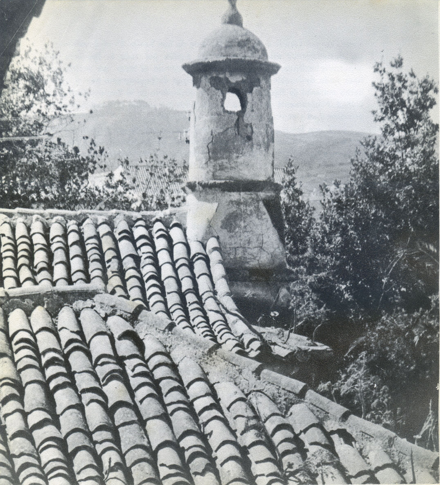
CHIMENEA EN LA CASA LERCARO
